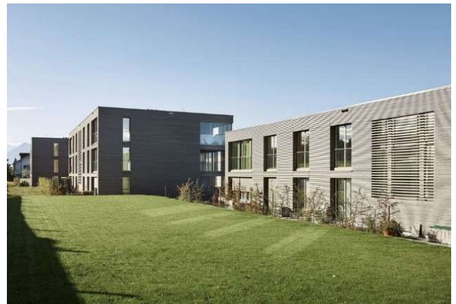
Wohnüberbauung Sandacher, Münsingen 38 Eigentumswohnungen (2017)
